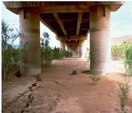
تصویر ۲-۹. اثرات وقوع روان‌گرایی در پی پل بالا بالا در اثر زمین‌لرزه ۱۳۶۹ منجیل
