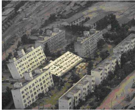
تصویر ۱-۹. کج شدگی ساختمان‌ها در اثر روان‌گرایی در زمین‌لرزه ۱۹۶۴ نیگاتا.
